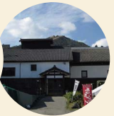
越後ゆきくら館(玉川涌道)
